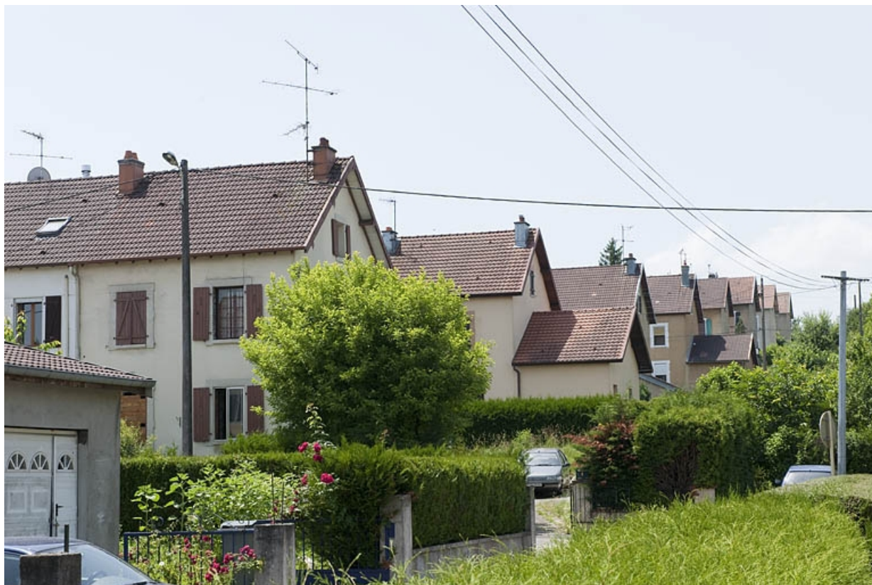
Pignons de maisons jumelées depuis le nord-est.
