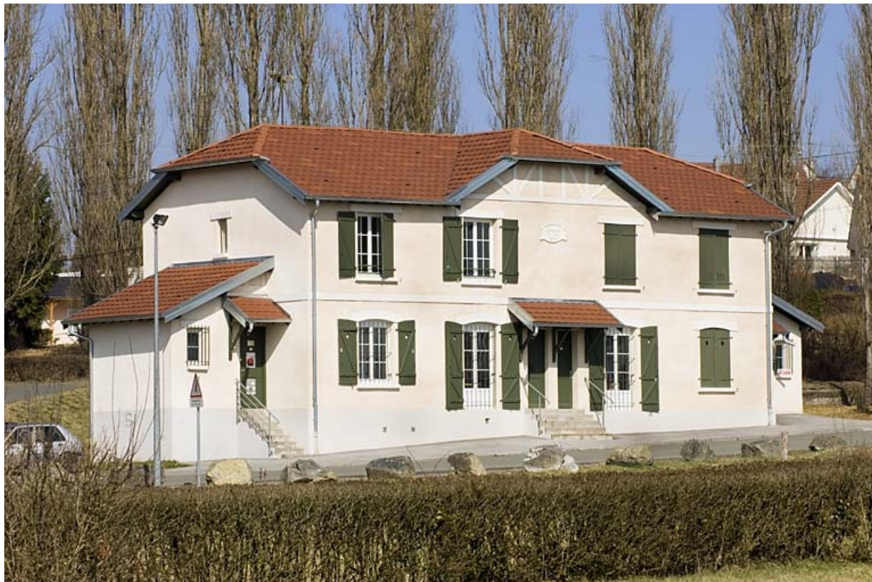
Habitation à 4 logements vue depuis le sud-ouest.
