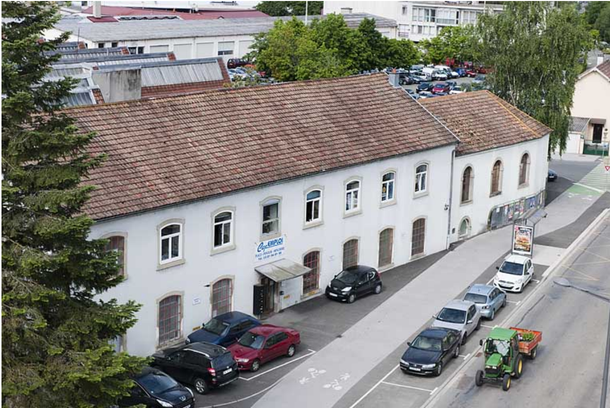
Vue plongeante sur le bâtiment administratif (?).
