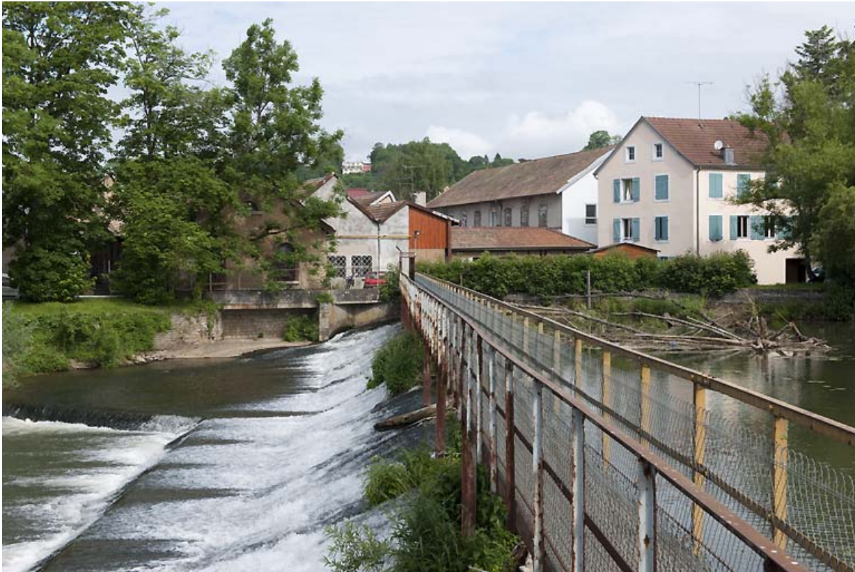
Vue d'ensemble depuis l'extrémité sud du barrage.
