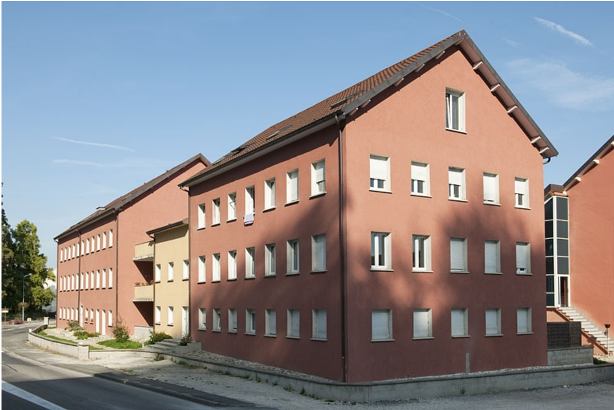
Ateliers de fabrication vus depuis le sud-ouest.
