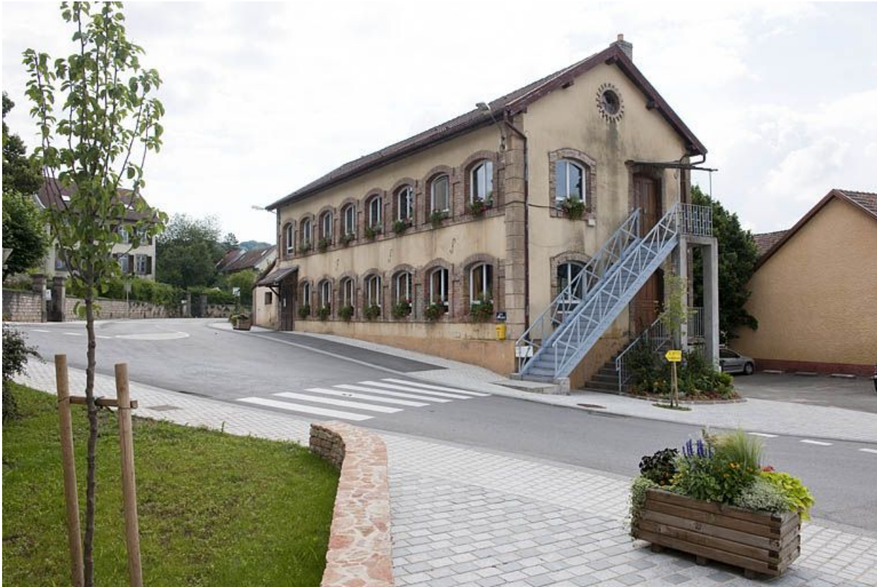
Vue rapprochée depuis l'ouest.
