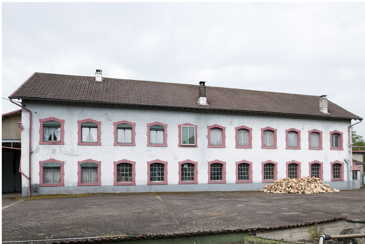
Atelier de fabrication. Façade antérieure.
