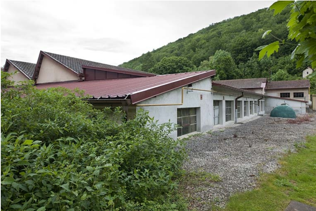
Façade postérieure de l'atelier de fabrication.
