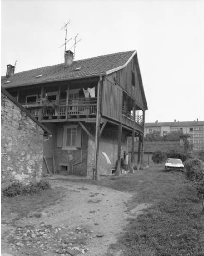
Pignon ouest en 1981.
