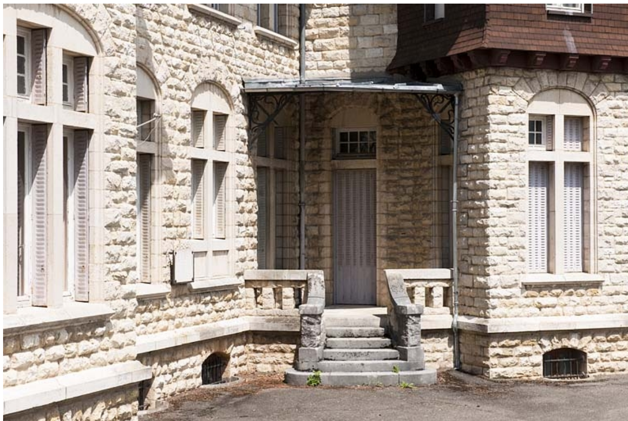
Détail de la façade sud.
