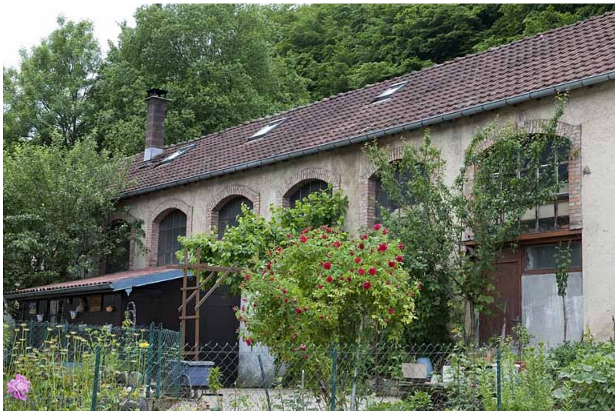
Façade est de l'atelier.
