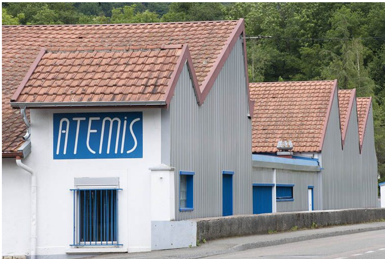
Pignons des sheds sur la route.
