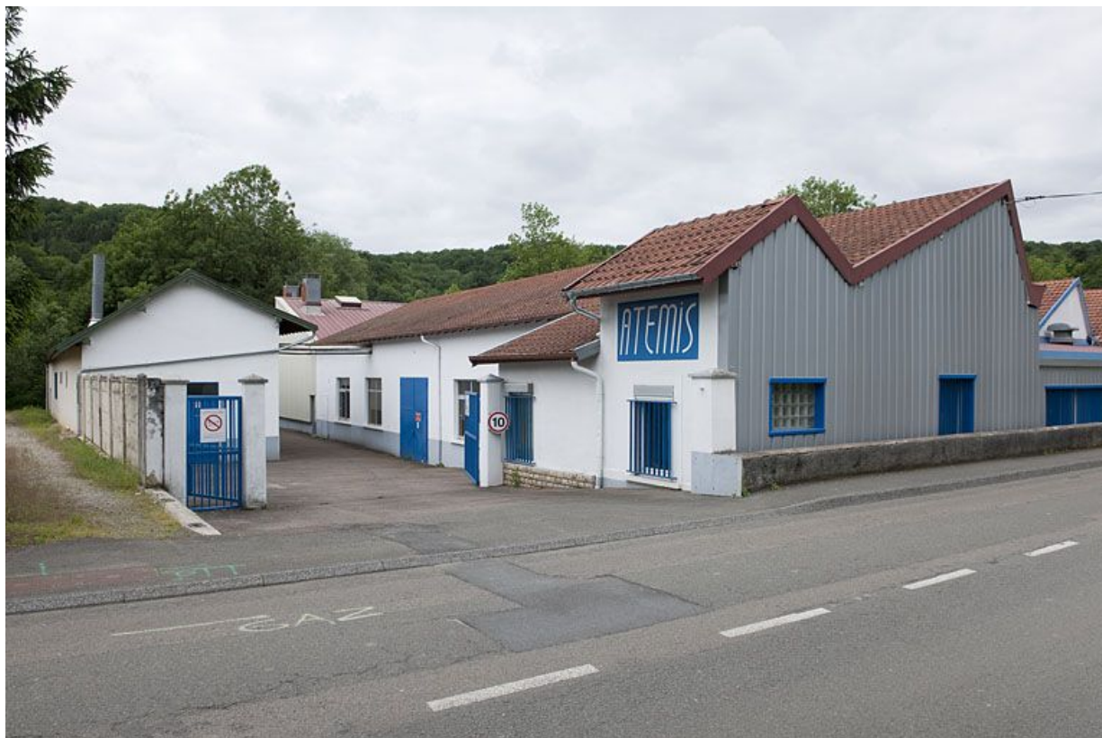
Bureau et atelier depuis le sud-est.
