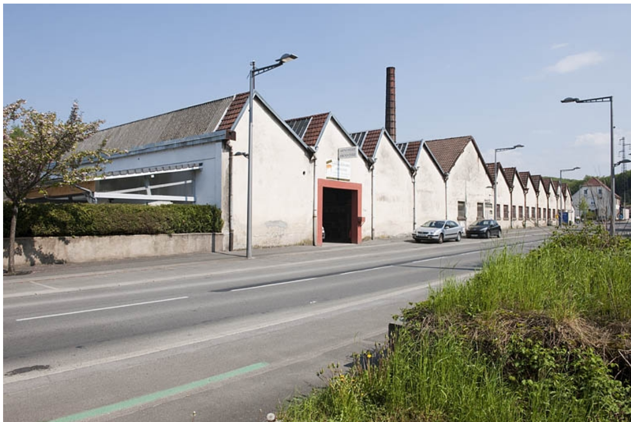
Atelier de laitonnerie depuis le nord-ouest.
