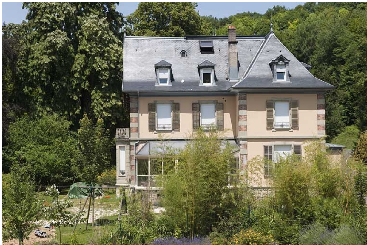
Logement patronal Paul Japy. Façade sud. 25, Seloncourt, lieudit : Berne
