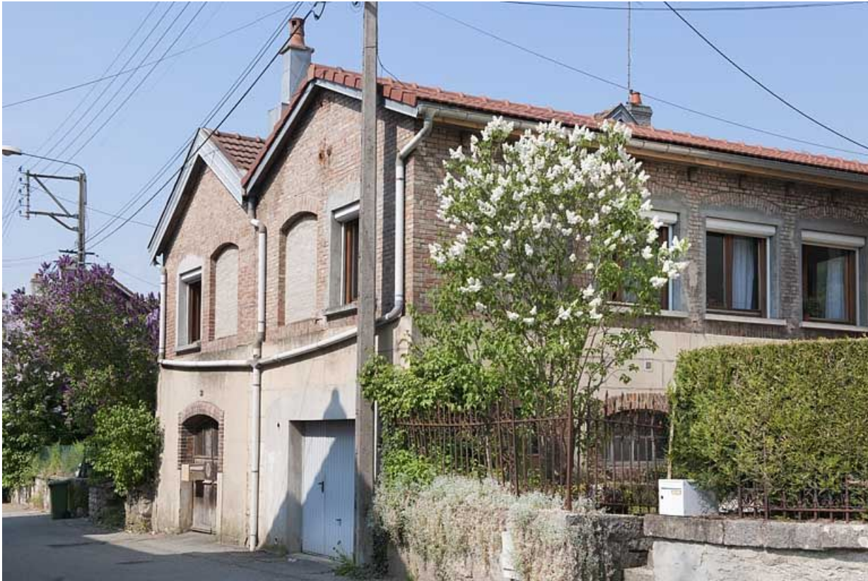
Vue de trois quarts depuis la rue.
