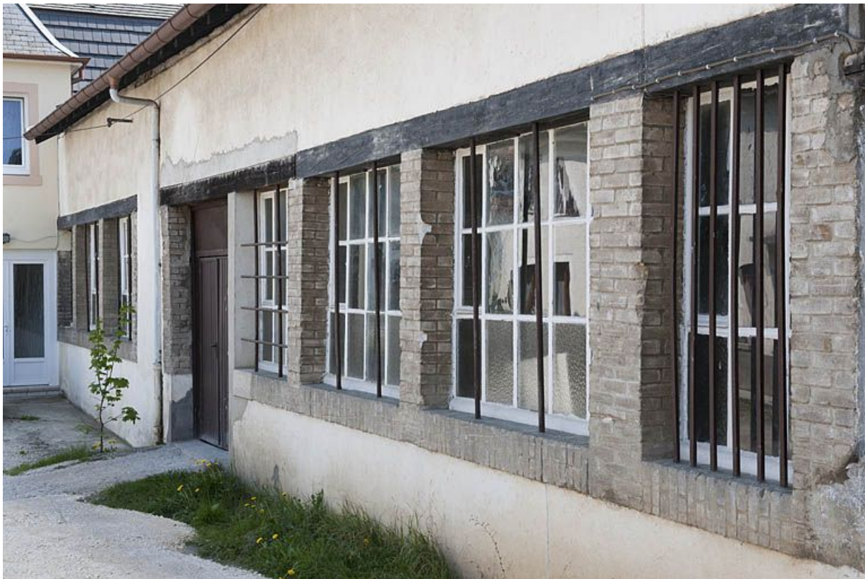
Mur nord de l'atelier de fabrication.
