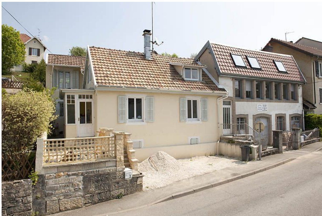
Logement et atelier depuis le nord-ouest.
