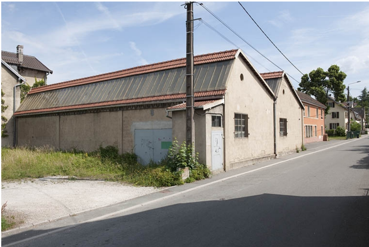
Atelier de fabrication. Extension occidentale.
