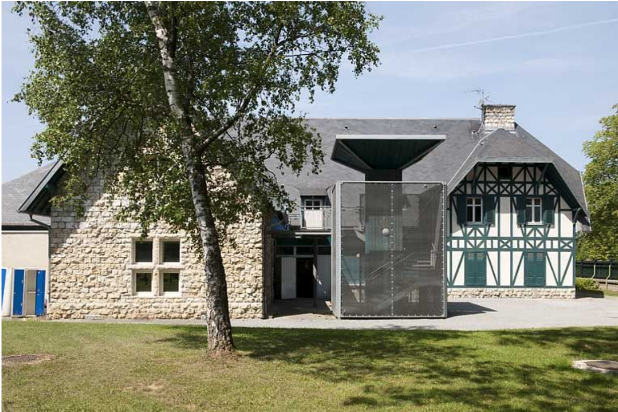
Façade est de la conciergerie.
