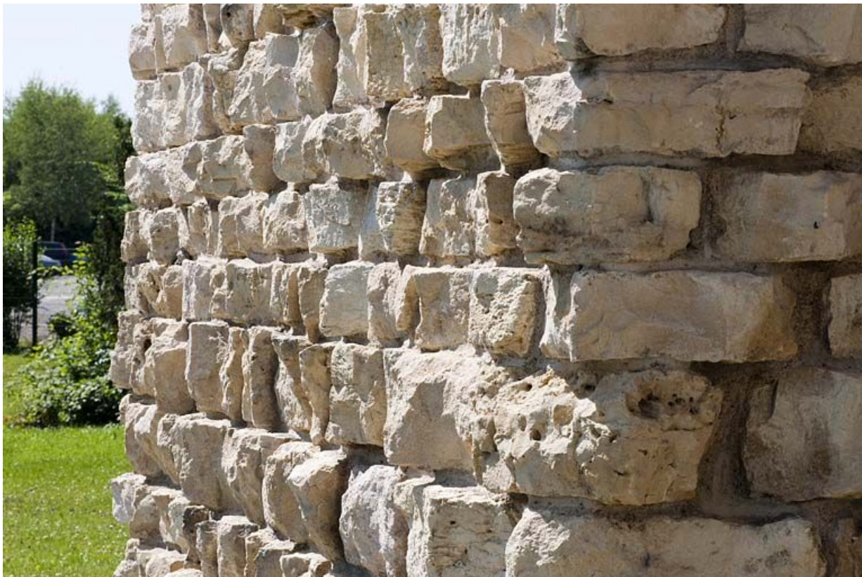
Mur pignon sud. Détail de la maçonnerie.
