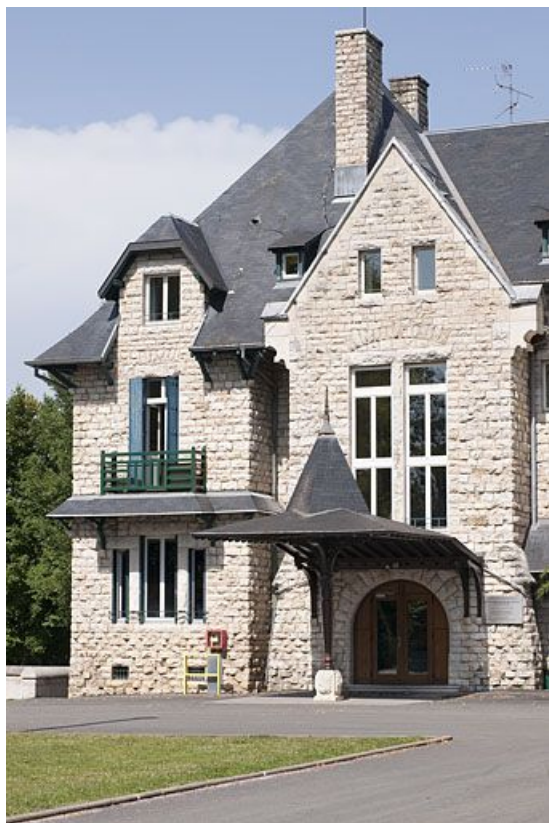
Partie nord de la façade antérieure.
