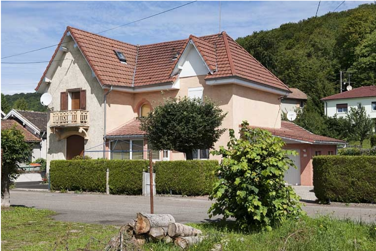
Maison de contremaîtres (n°12-14).
