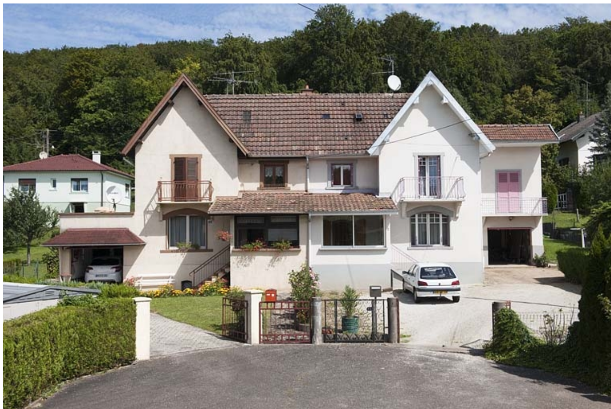
Maison de contremaîtres (n°8-10).
