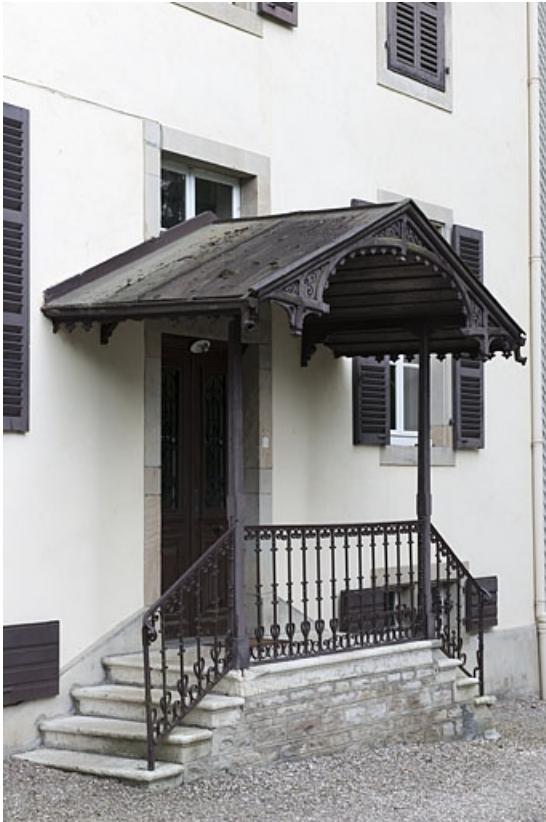
Entrée de la façade nord.
