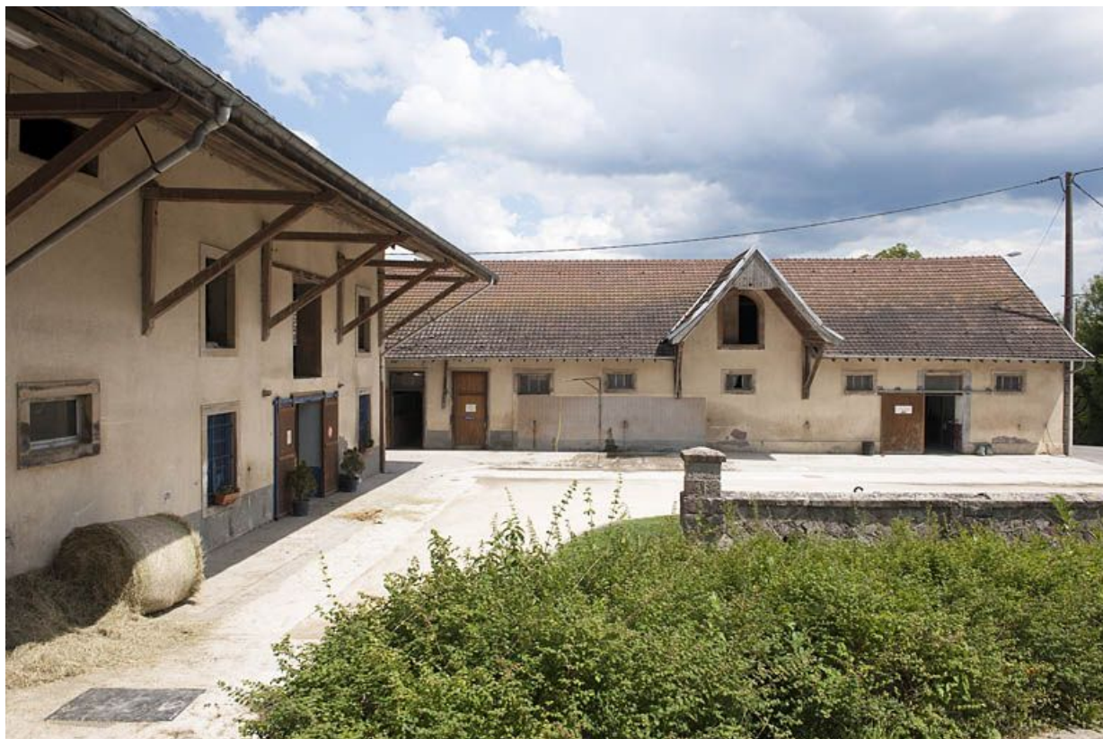
Bâtiments agricoles depuis le sud.
