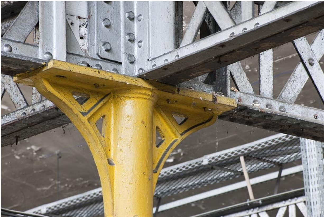
Détail d'une console de colonne et de poutrelles à treillis.
