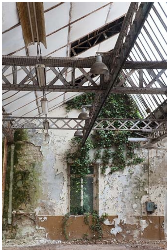
Atelier de fabrication. Travée de shed.
