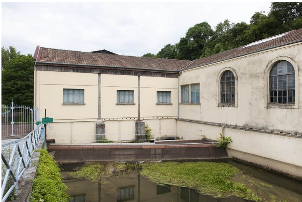
Bâtiment d'eau vu depuis l'amont.
