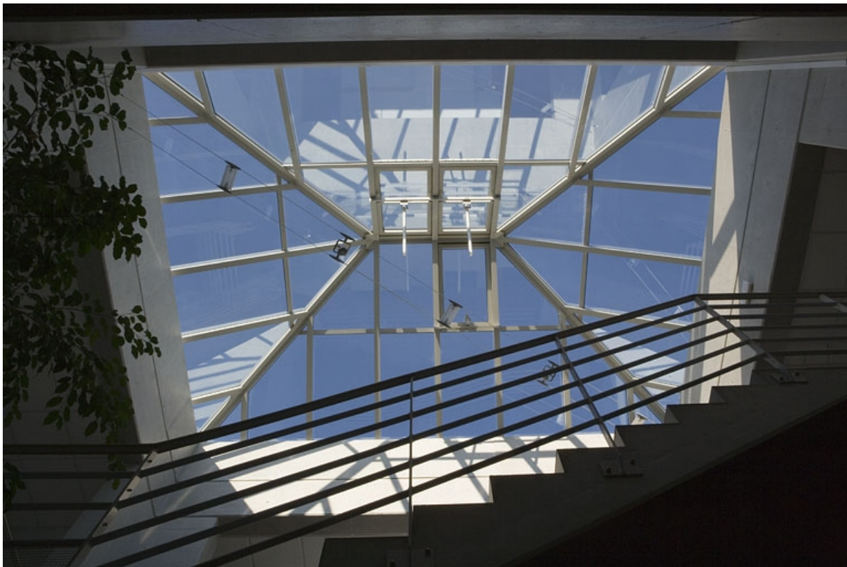
Bâtiment A. Détail de la verrière.
