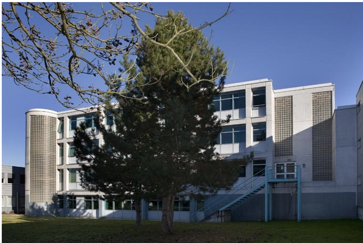
Bâtiment B. Vue de la façade antérieure.
