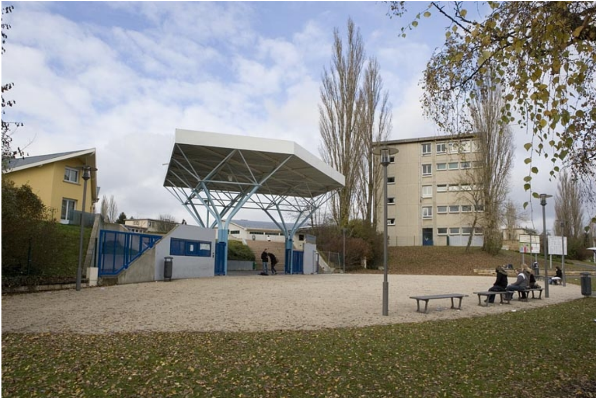
Vue de la nouvelle entrée.
