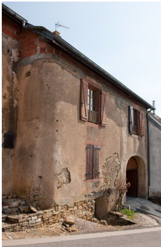
Vue rapprochée de la façade antérieure.
