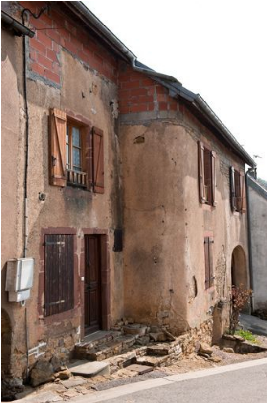
Façade antérieure, vue de trois quart gauche.
