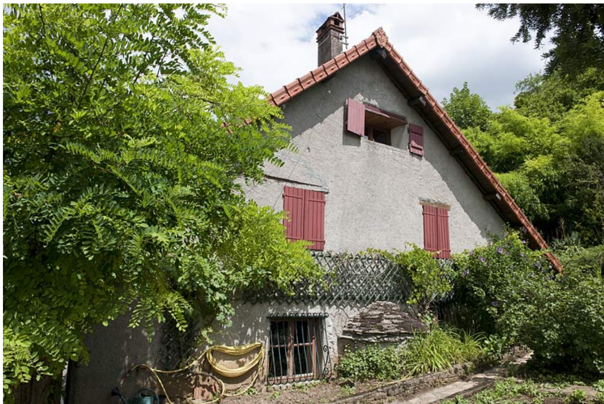
Façade latérale droite.
