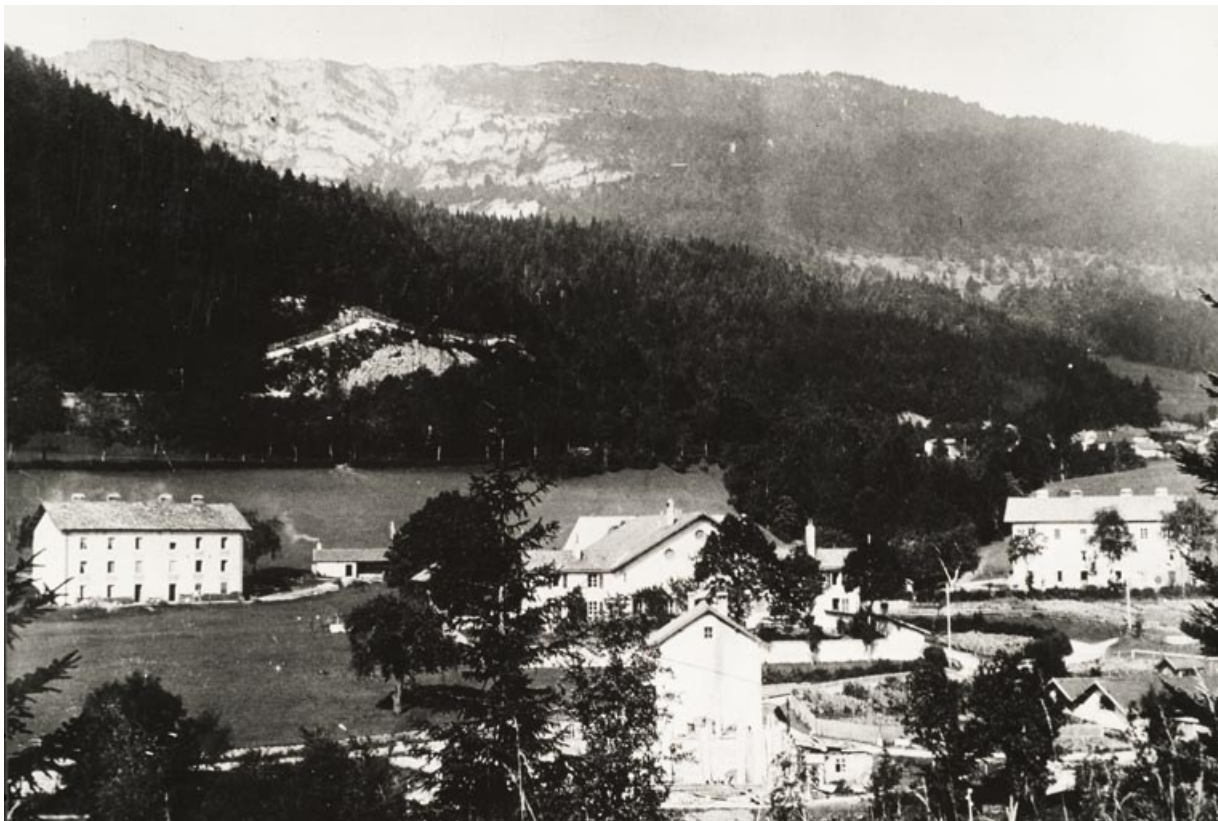
Vue générale après l'incendie de 1913
