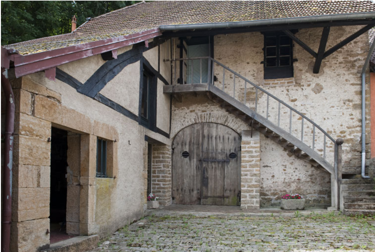
Vue générale des communs depuis l'entrée.
