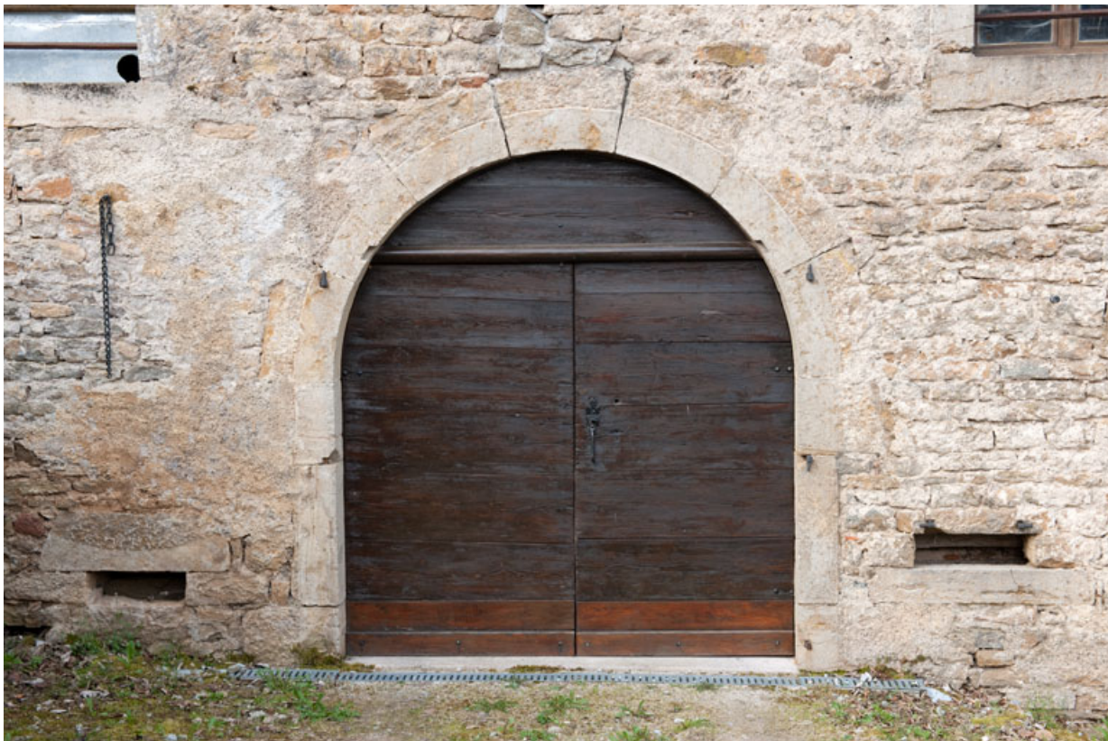
Grange : porte sur la façade latérale gauche.
