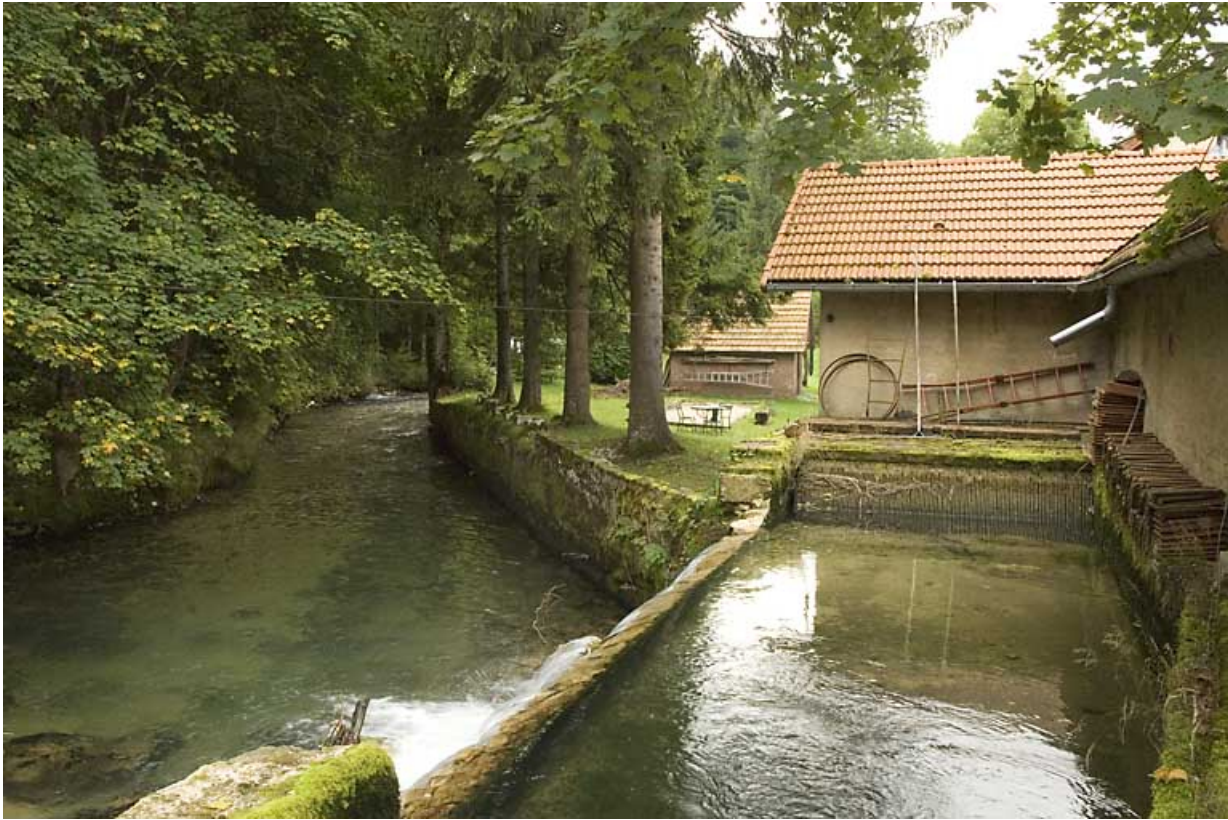
Canal d'amenée (avec déversoir à gauche) et bâtiment d'eau.
