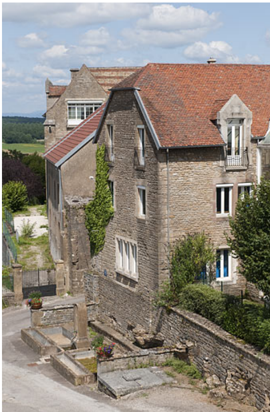
Bâtiment (A), vue rapprochée du côté rue.
