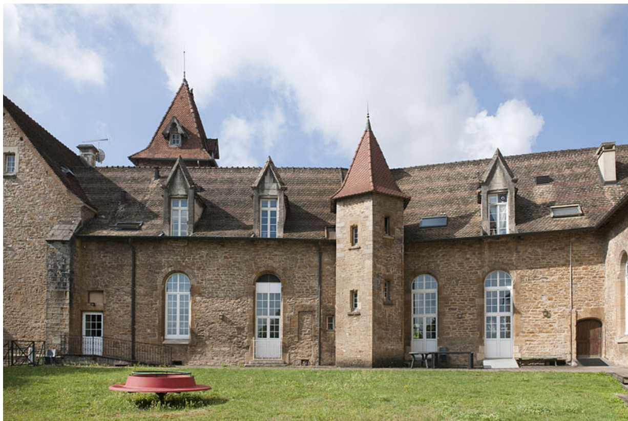
Bâtiment (C), vue d'ensemble côté jardin.
