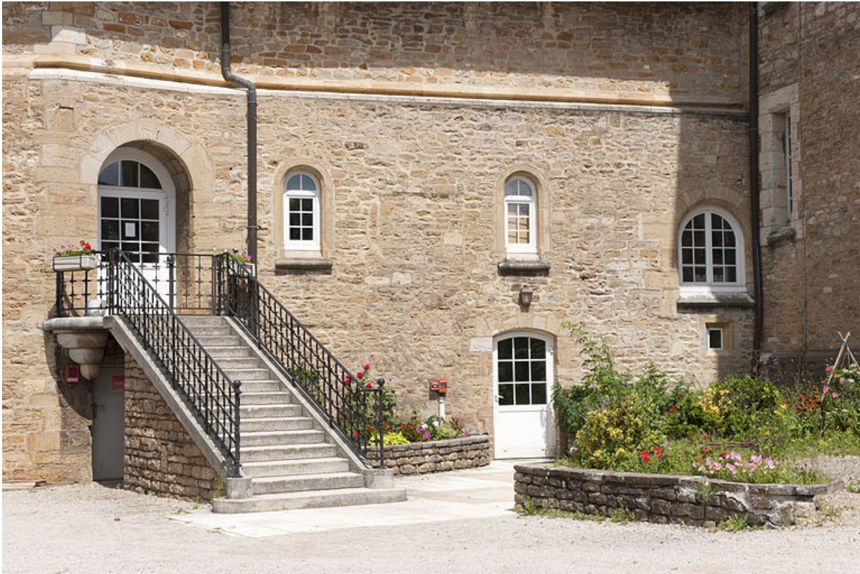
Bâtiment (C), escalier côté cour.
