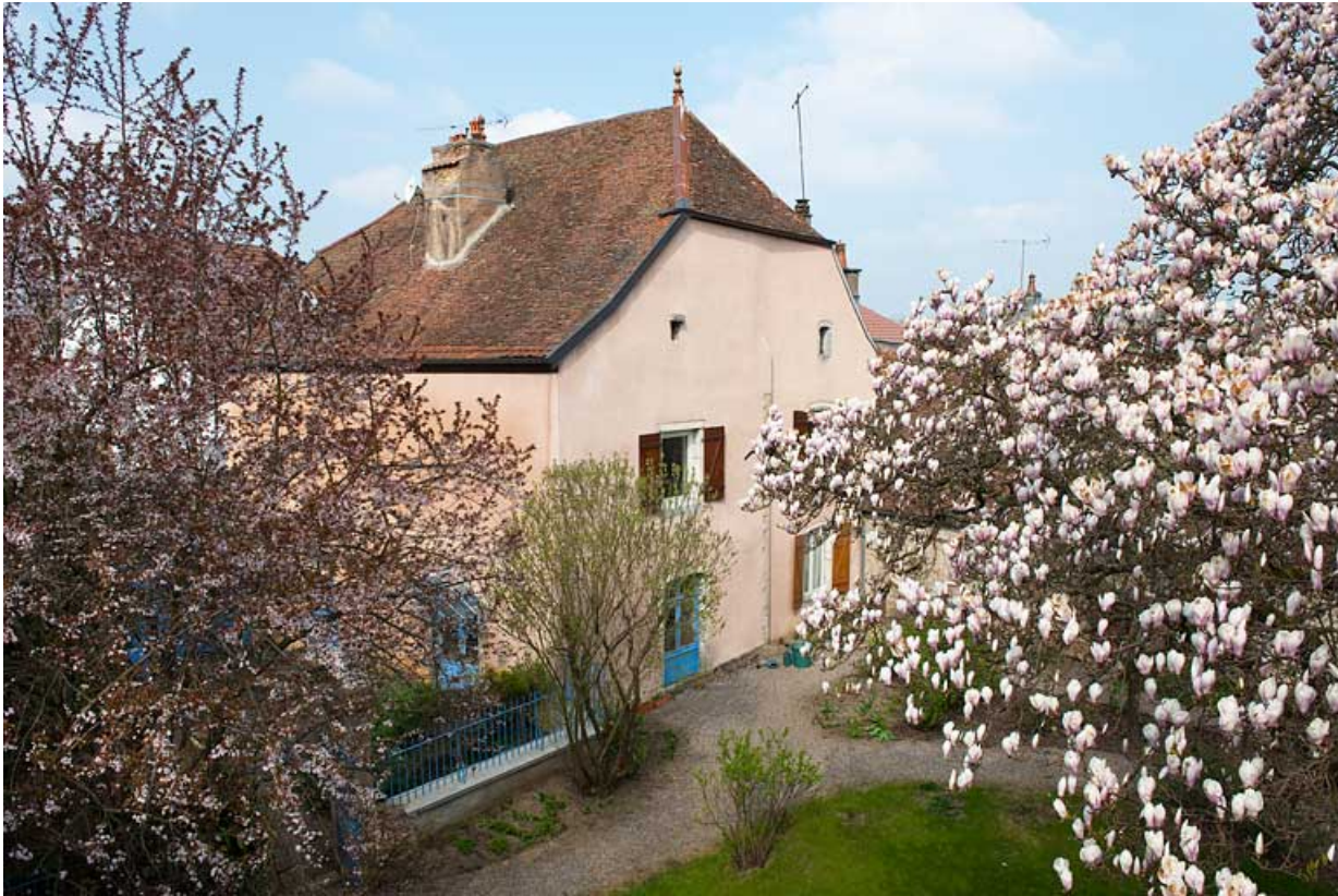
Façade postérieure de trois quart gauche.
