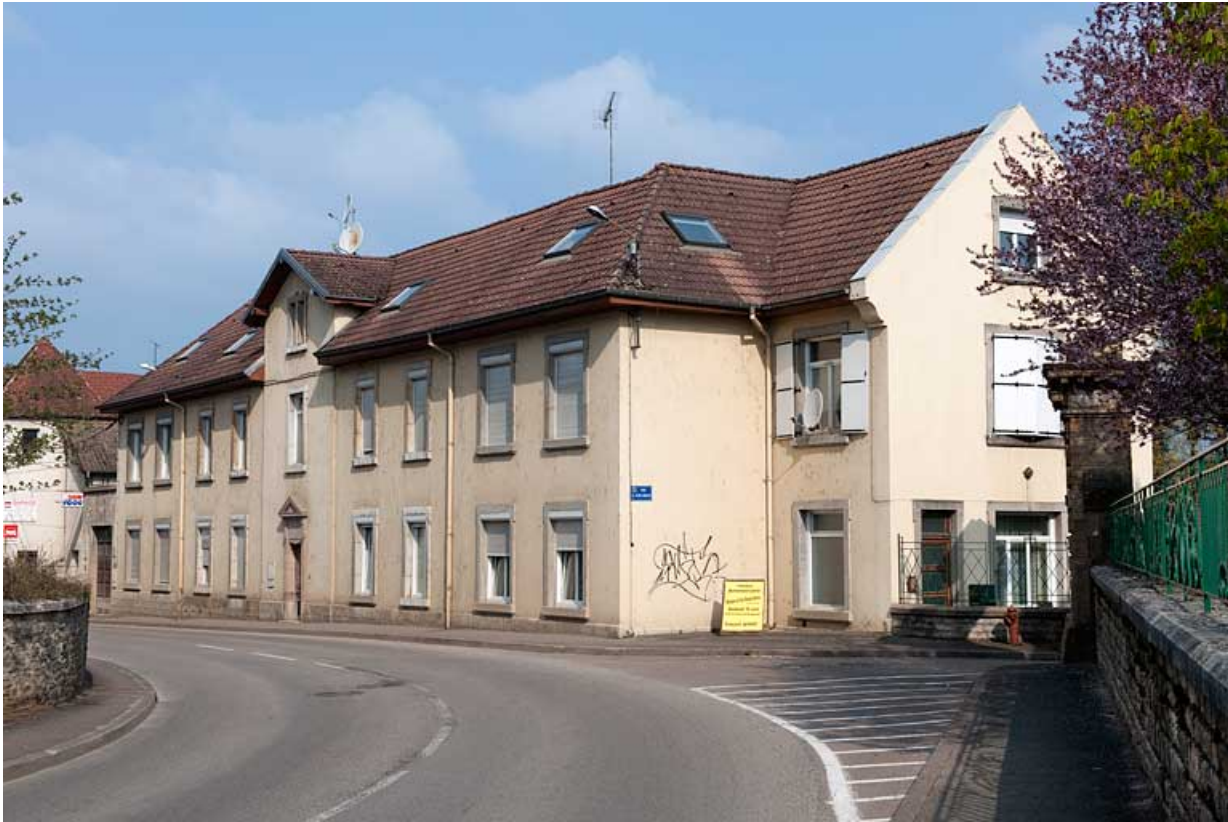
Vue générale de l'ancien pavillon d'isolement.
