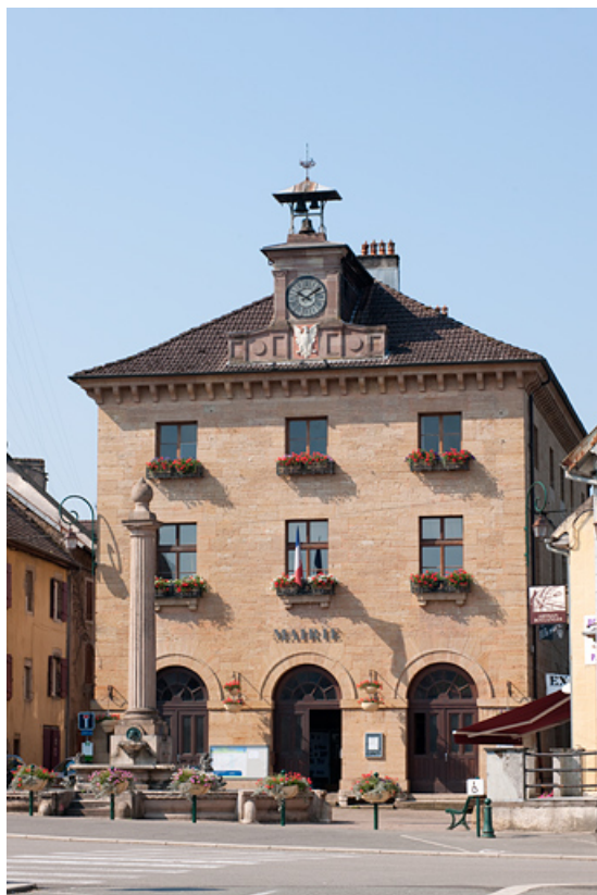
Façade antérieure de trois quart droit.
