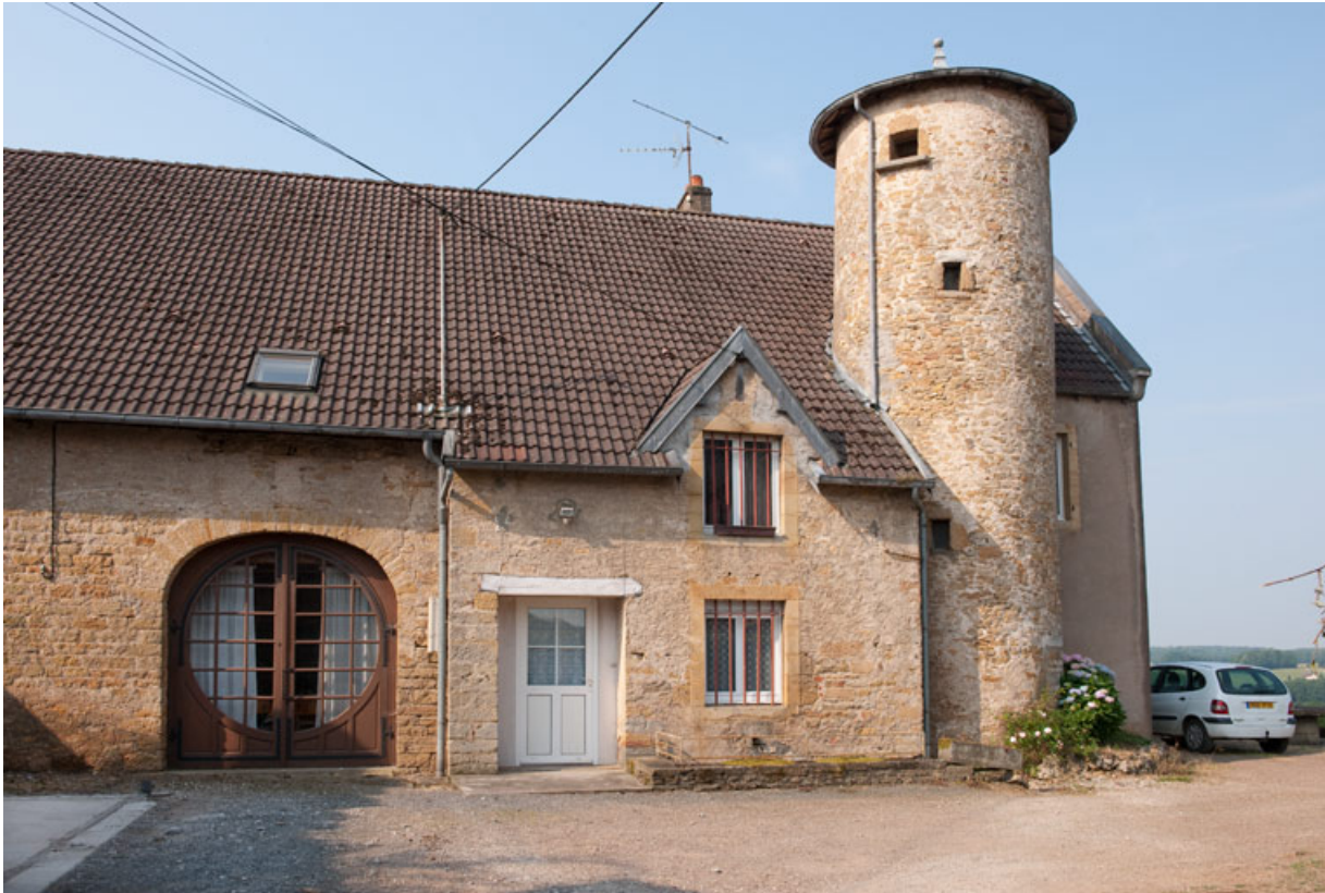
Façade antérieure vue de trois quart gauche.
