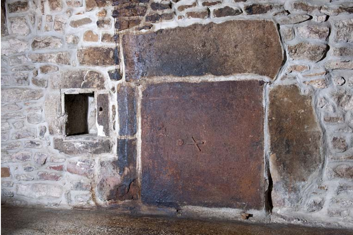
Détail de la cheminée
