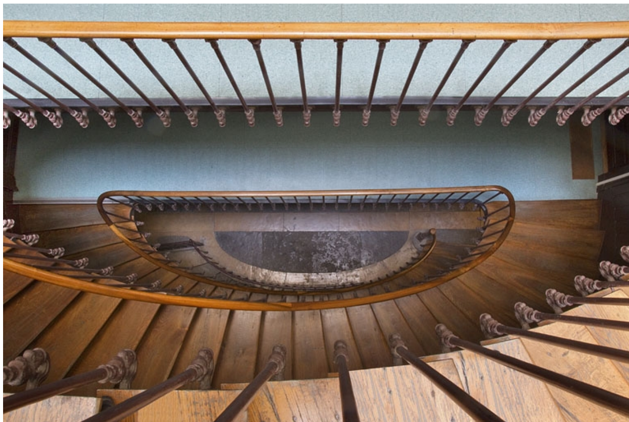
Intérieur, escalier : vue plongeante.
