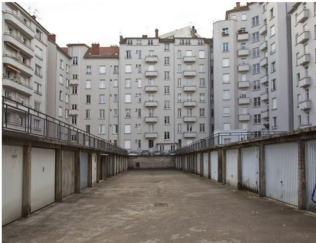
Cour des garages, de face.
