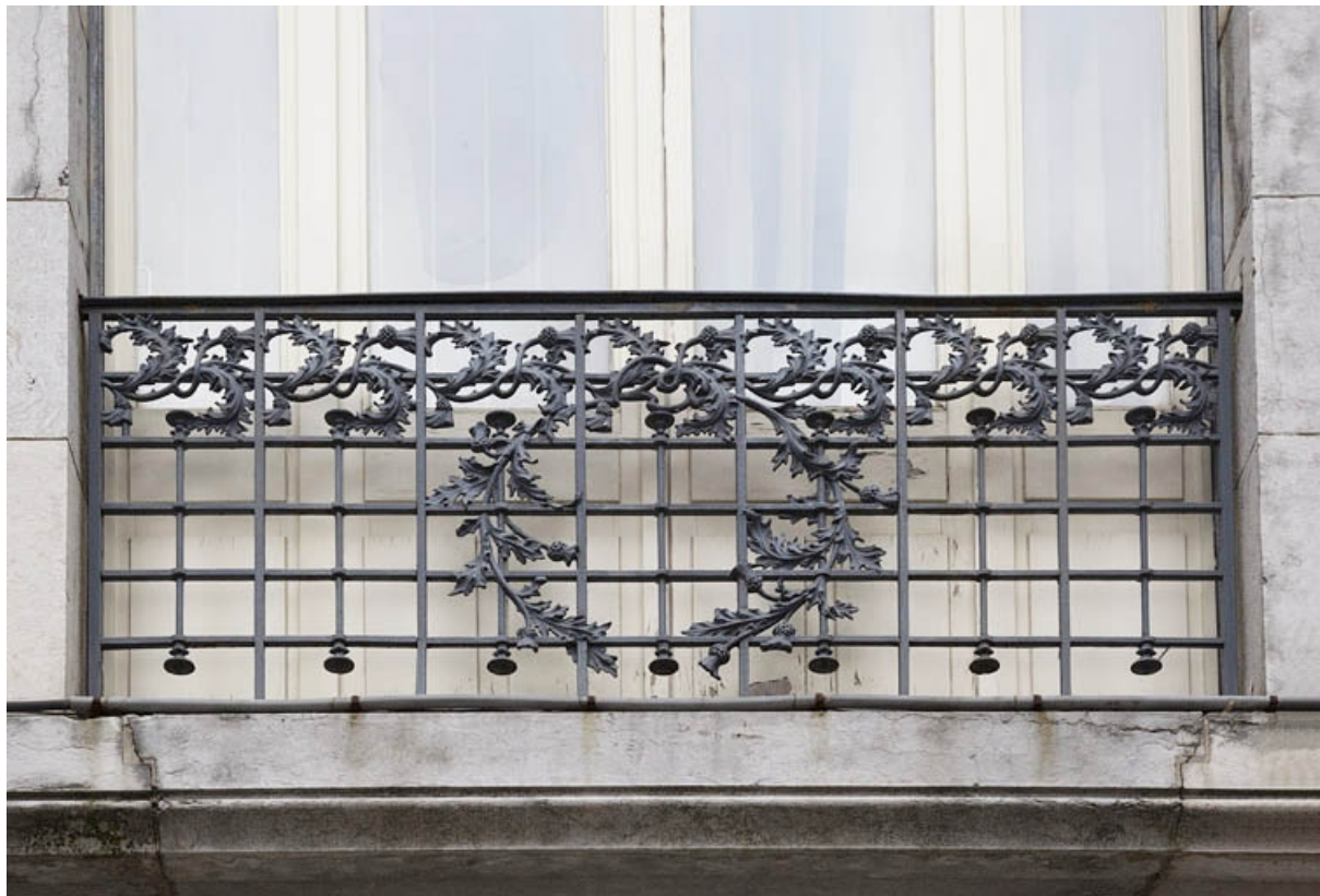
Détail du balcon d'angle du premier étage.
