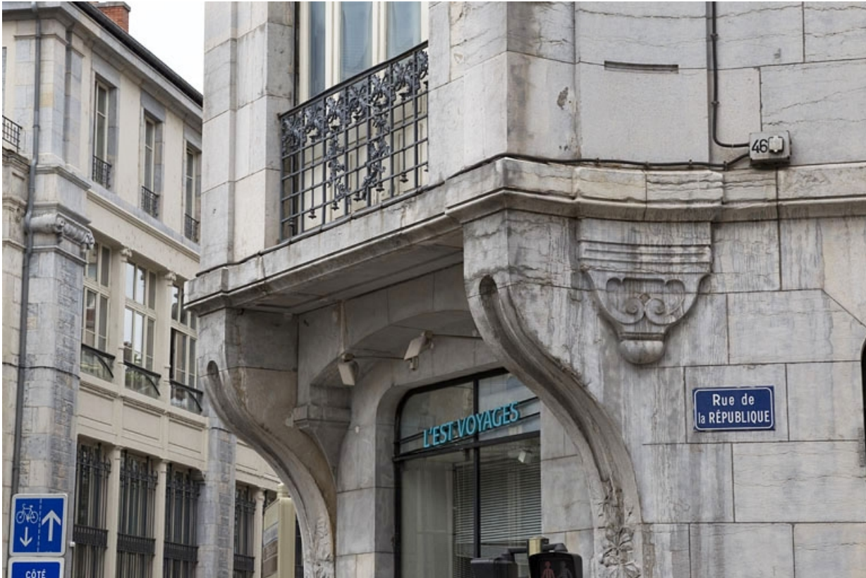
Façade d'angle : détail du rez-de-chaussée.
