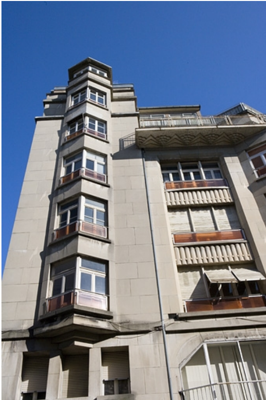
Façade antérieure : détail de la partie gauche.
