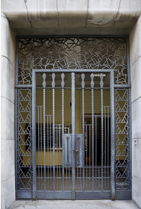
Portail d'entrée : détail de la grille.
