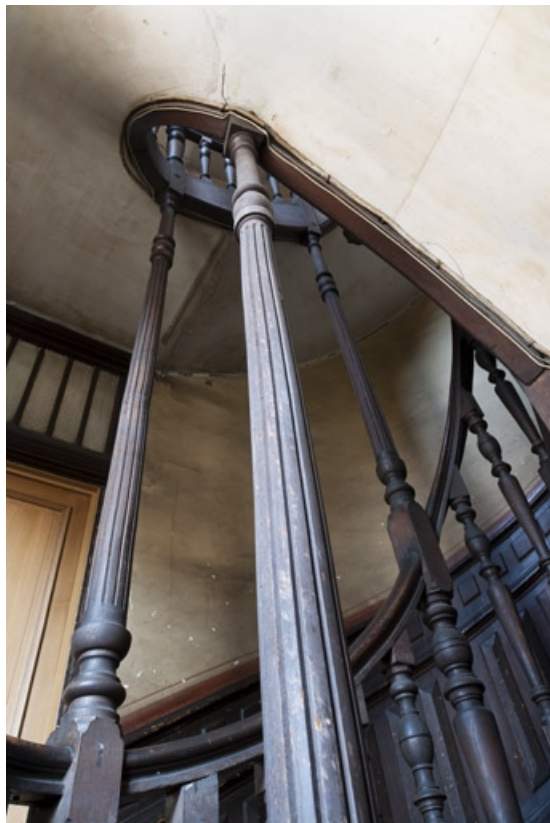
Détail des montants de l'escalier.
