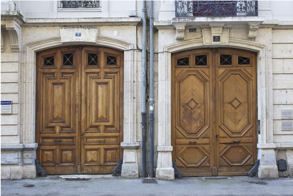
Façade antérieure : détail du portail d'entrée.
