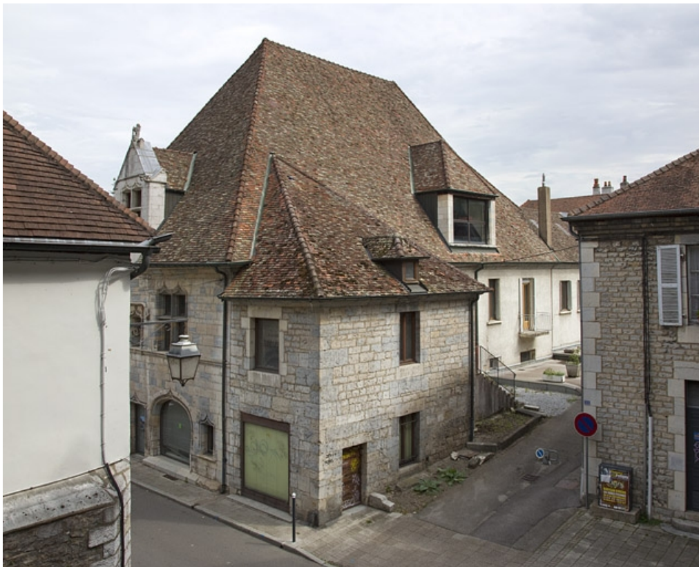
Façade rue Rivotte, de trois quarts droit.
