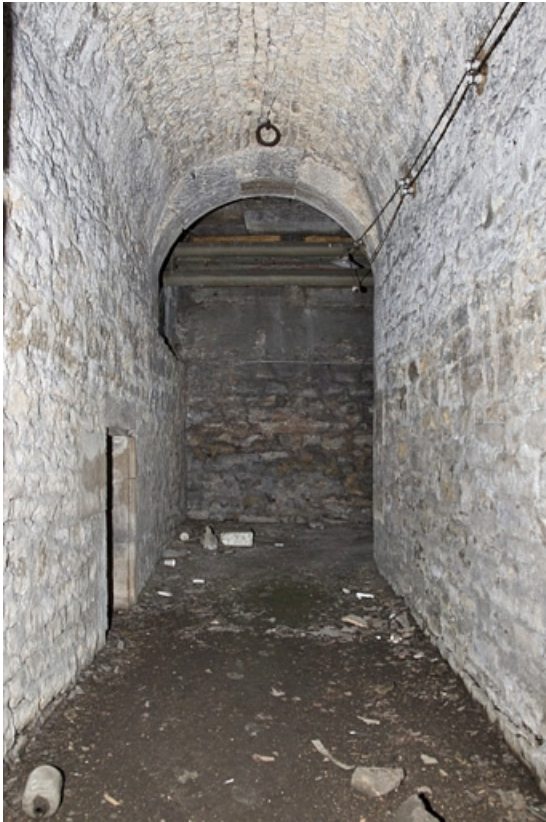
Sous-sol : détail d'un couloir voûté en berceau.
