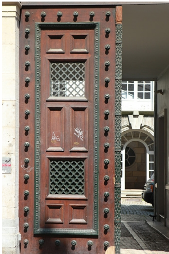
Détail d'un vantail du portail d'entrée.
