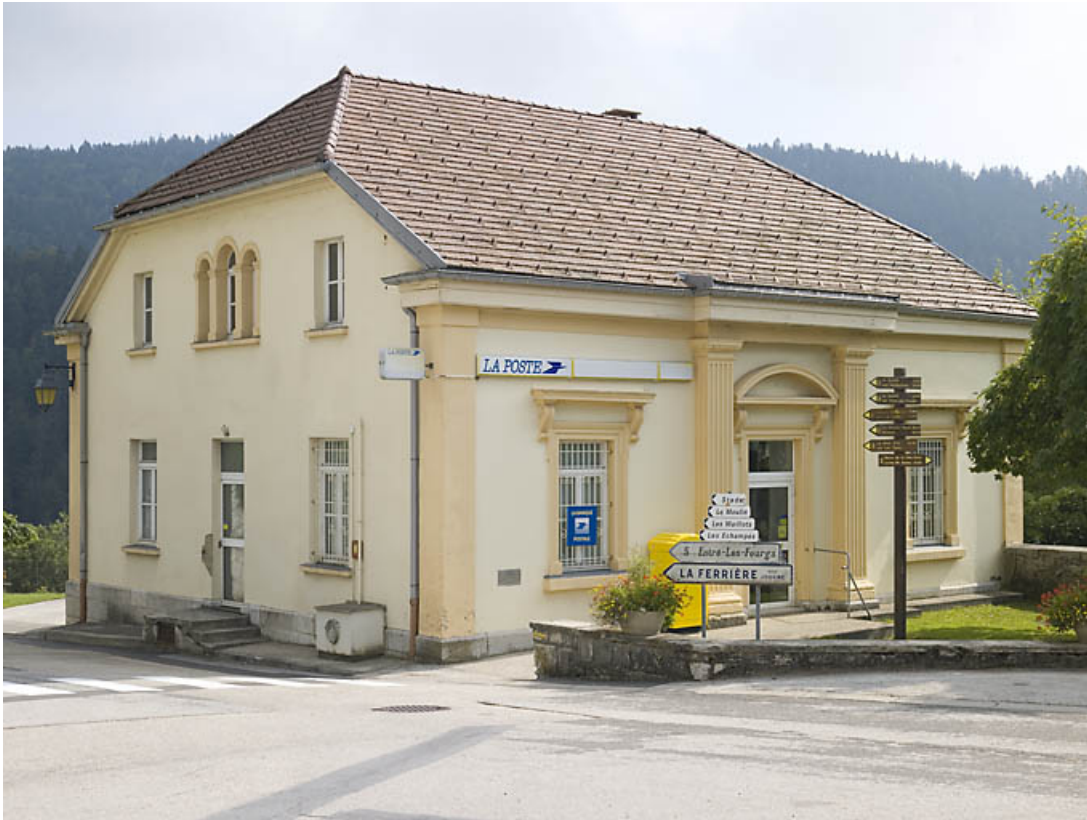
Façade antérieure et façade latérale gauche.
