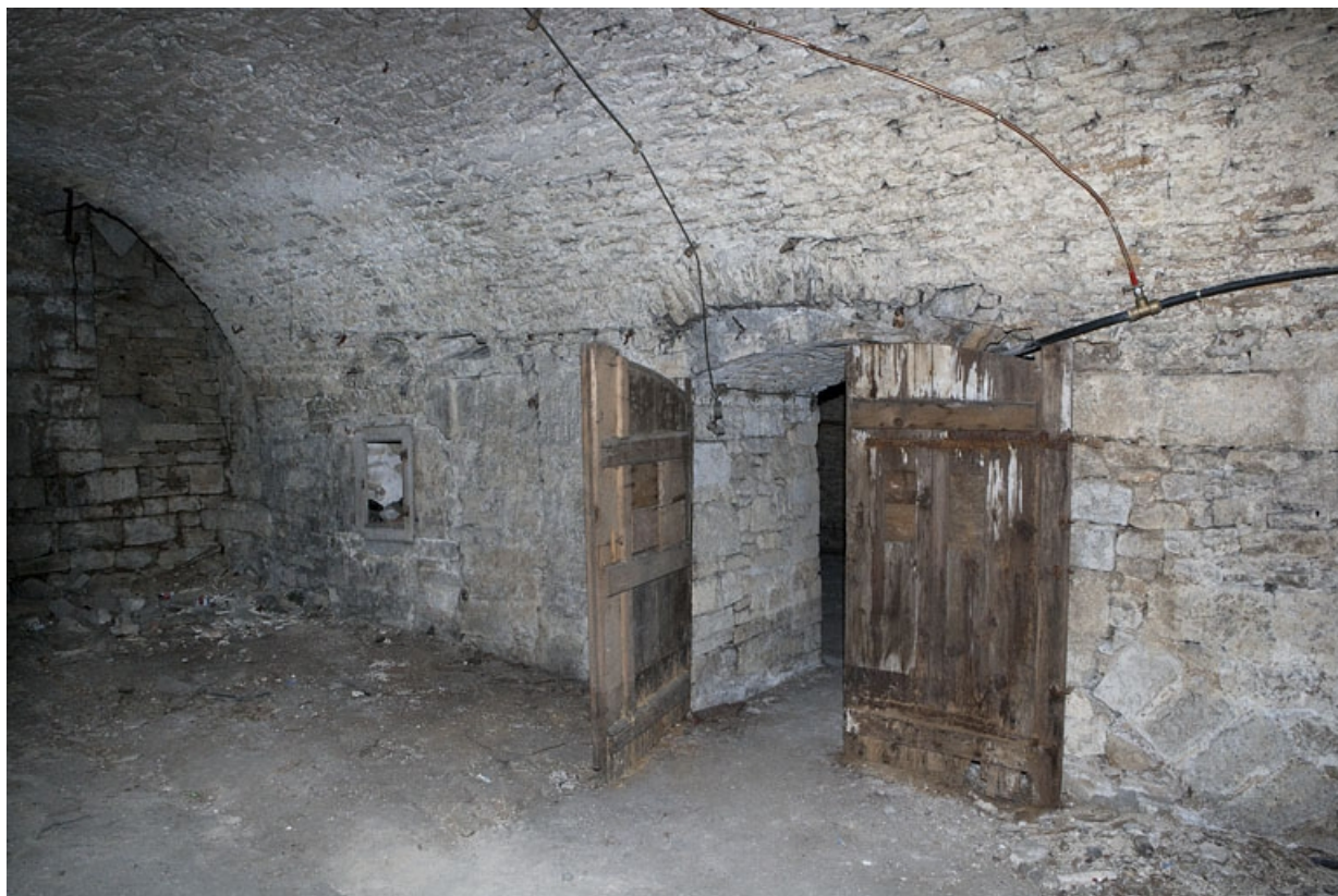
Logis principal, sous-sol : cave C.
