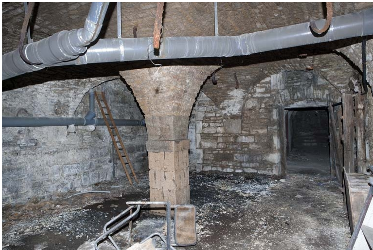
Logis principal, sous-sol : cave B, vue d'ensemble.
