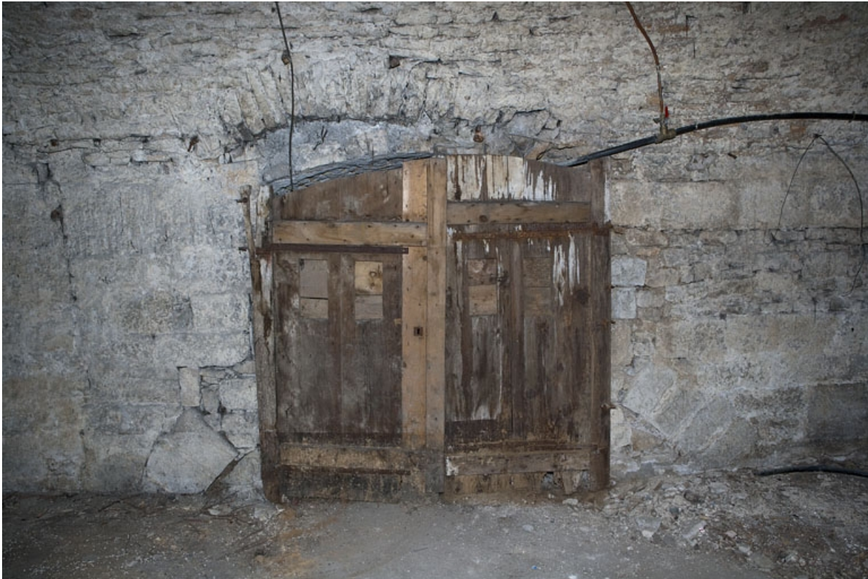
Logis principal, sous-sol : cave C.
