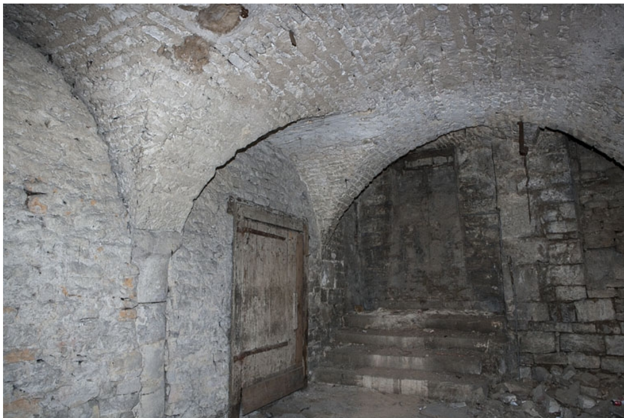
Logis principal, sous-sol : cave C.
