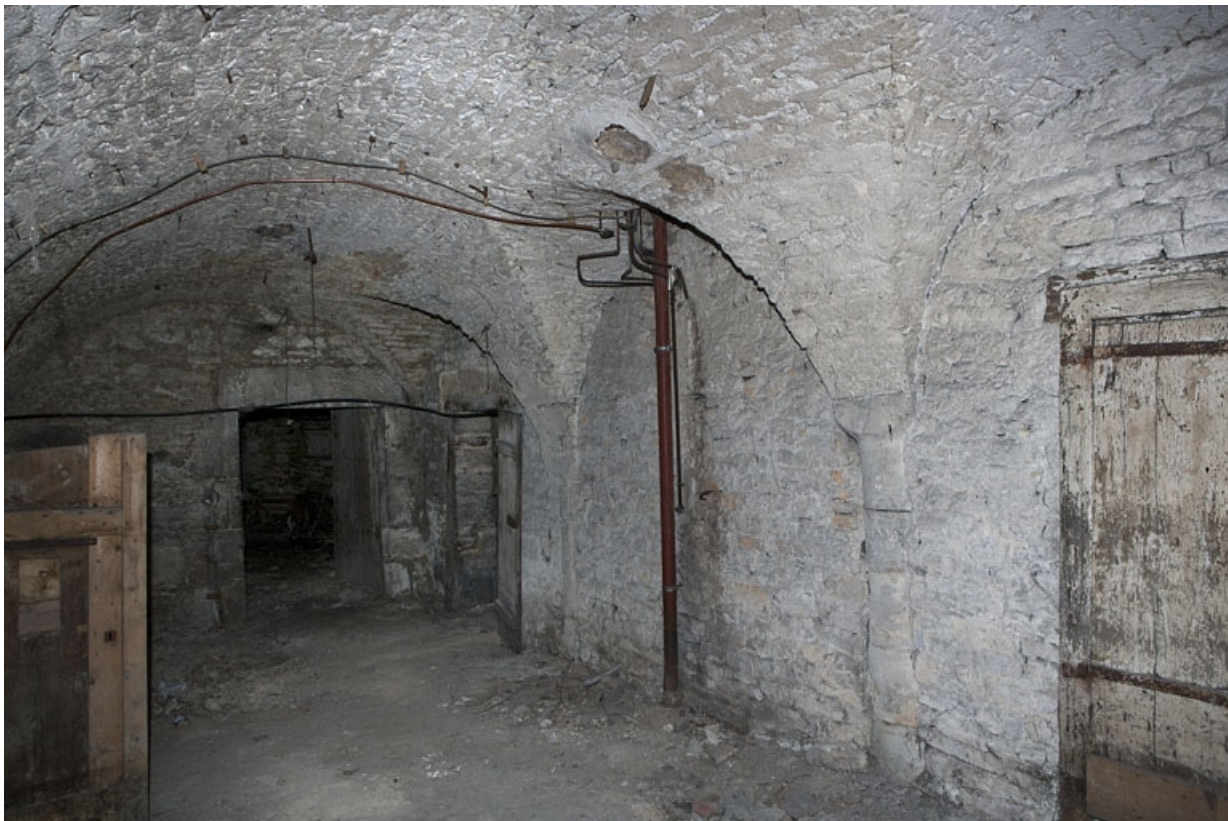
Logis principal, sous-sol : cave C.
