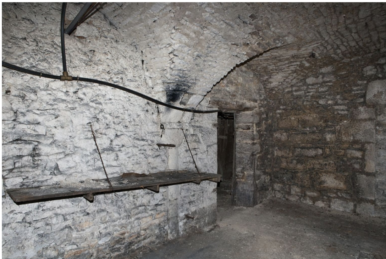
Logis principal, sous-sol : cave C.
