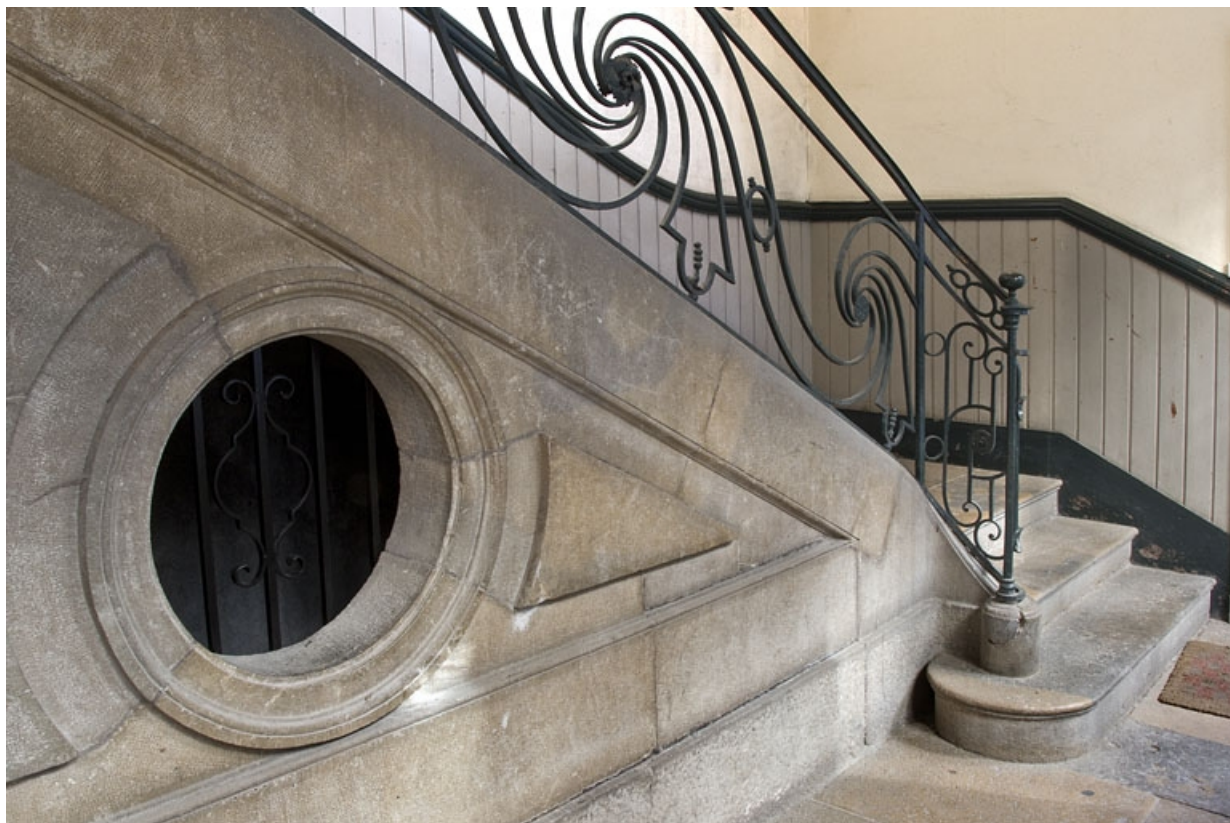
Logis principal : détail du départ de l'escalier.
