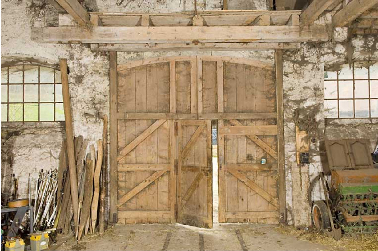
Grange haute : porte vue de l'intérieure.
