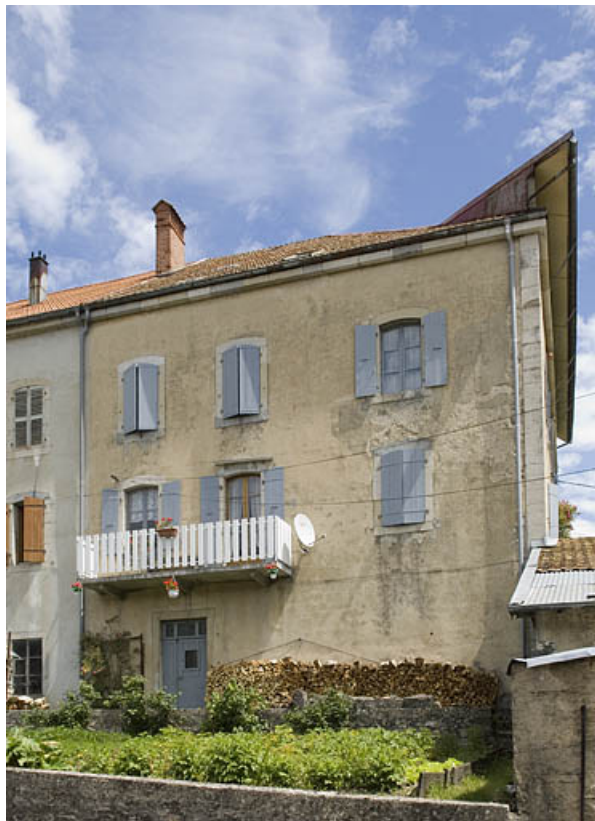
Façade postérieure de la partie sud.
