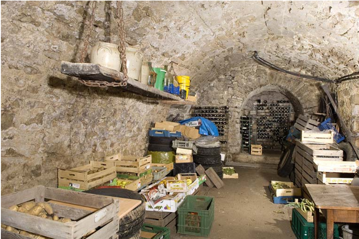
Sous-sol ("cave") voûté en berceau.
