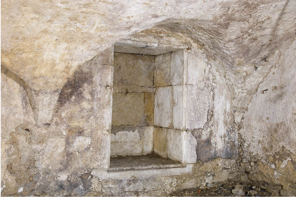
Sous-sol : détail, niche.
