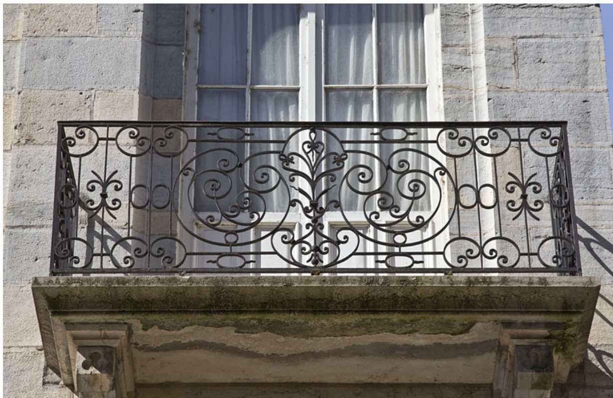
Logis principal : détail d'un balcon en ferronnerie.
